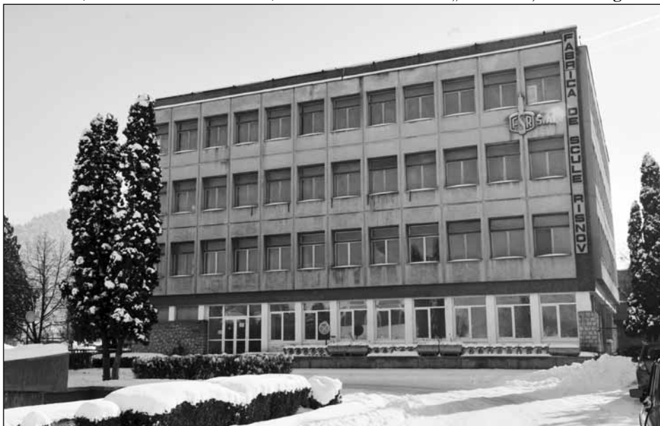
Viitorul hotel va fi amenajat pe structura fostului sediu administrativ FSR
